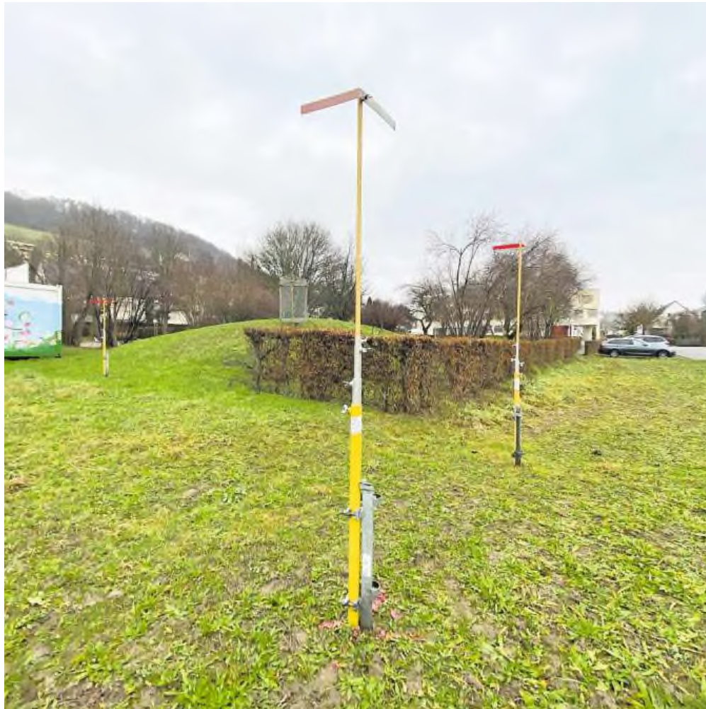
Auf dem Areal der Arwo zeigen die Bauprofile an, wo das Provisorium hinkommen soll.
