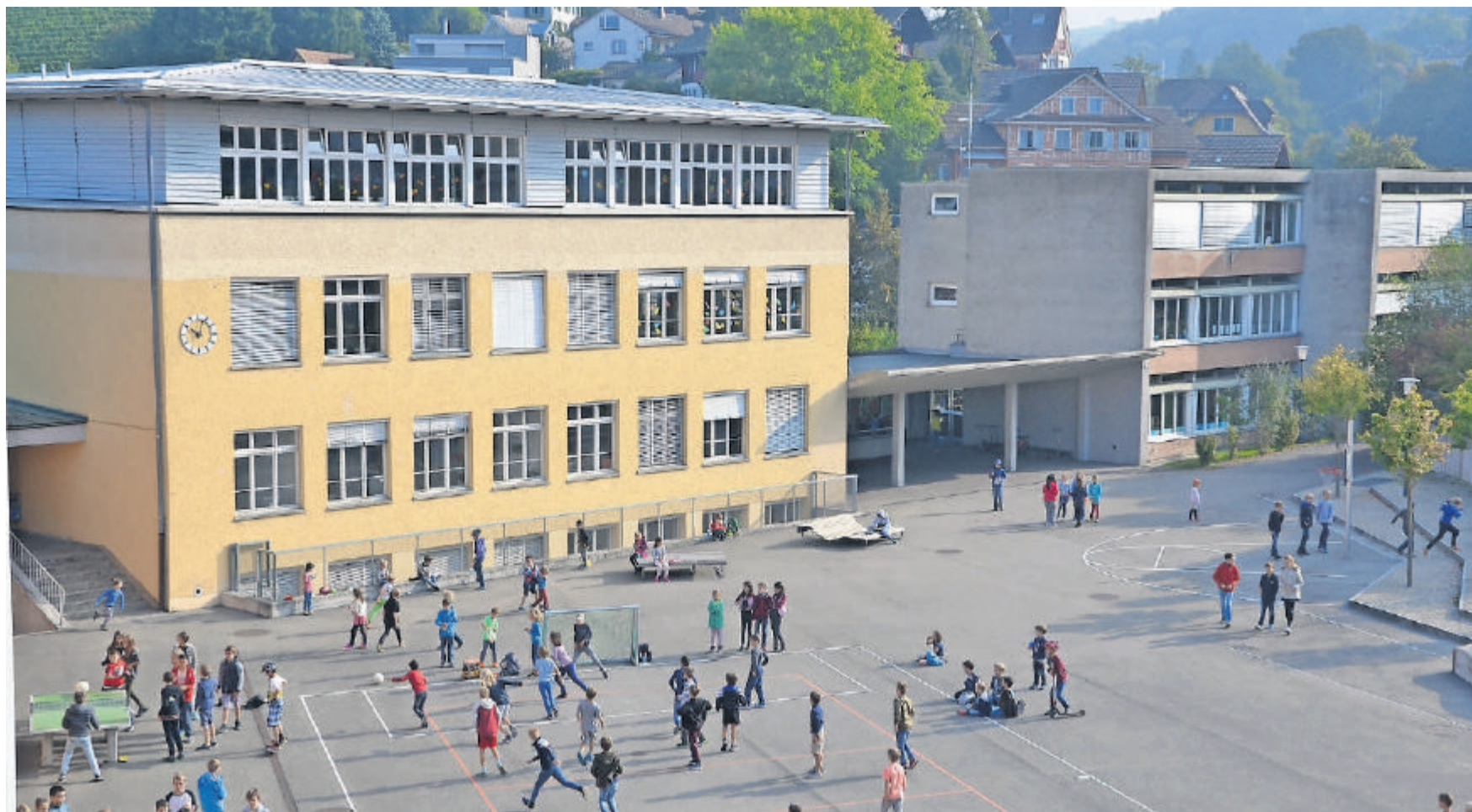
Die Schulbauten aus den Jahren 1937 und 1964 sollen rundum saniert werden. Aufgrund steigender Schülerzahlen und neuer Schulformen soll auch ein Neubau her. ZVG
